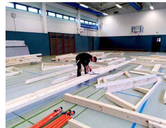
Montage der Unterkonstruktion
