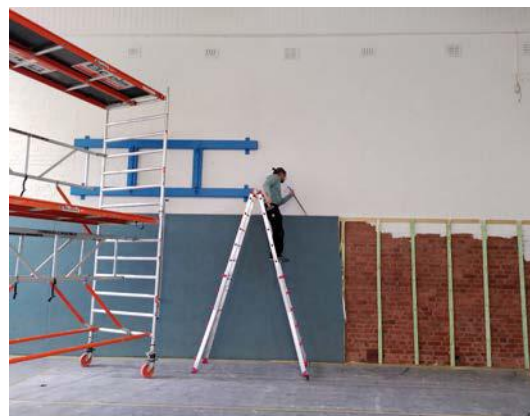
Vorbereitung der Wand
