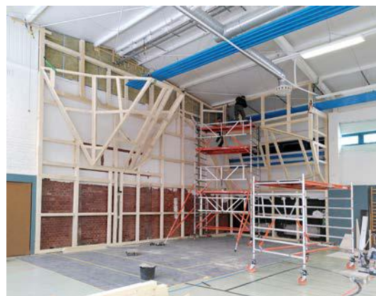
Aufgestellte Unterkonstruktion
