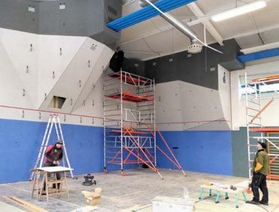
Verbundplatten fertig montiert
